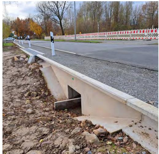
Abb. 2: Eine weitere dauerhafte Schutzanlage am Horstheider Weg mit Tunnel, Leitsystem und Auffangroste. Foto: Stadt Bielefeld.
