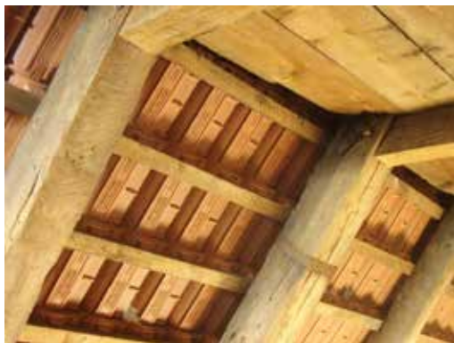
Abb. 5: Zweites Dachgeschoss, Sparren und Kehlbalcken mit Abbundzeichen. Foto Lutz Volmer 2008
