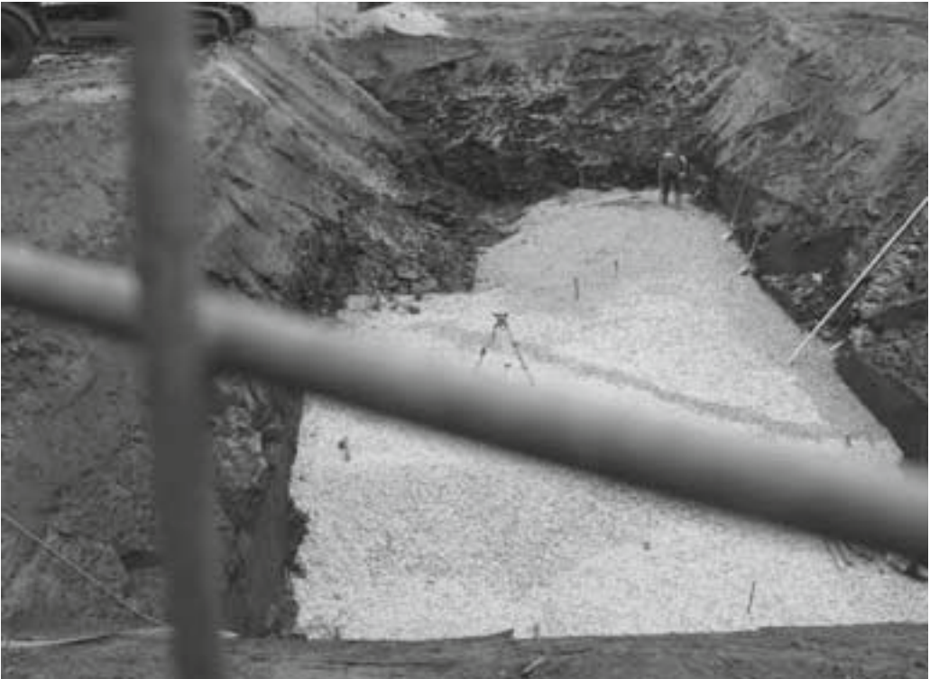
Abb. 2 : Baugrube mit schnellem Vortrieb ohne Möglichkeiten zum genauen Erkunden der Stratigraphie.
