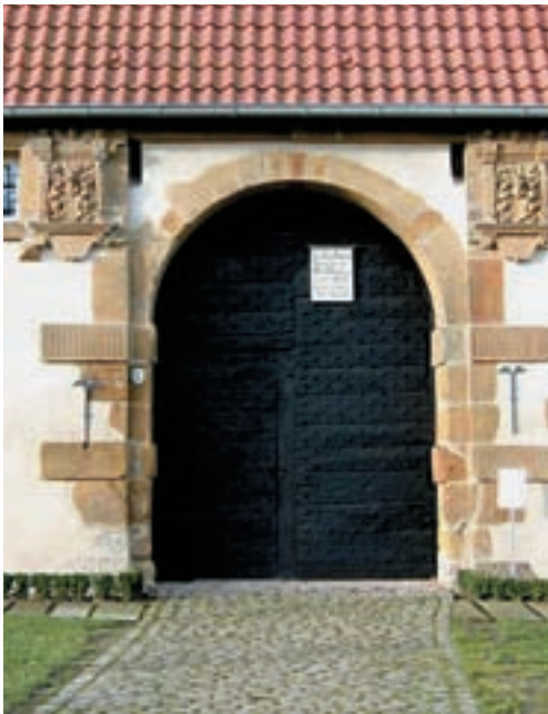
Ostportal des Werburger Torhauses, erbaut im Jahre 1596. Als Sichtmauerwerk wurde hauptsächlich der gelbbraune Osningsandstein (Unterkreide) verwendet.
